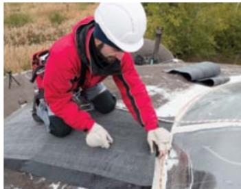
для обрезки подкладочных ковров: необходимо отбить шнуркой вертикальные линии от центра купола до каждого края подкладочного ковра в основании купола.
