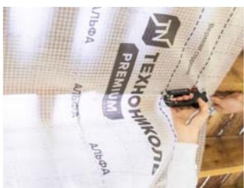
Первоначальное (временное) крепление пленки к древесине выполнить с помощью скоб из нержавеющей стали или оцинкованными гвоздями с плоской головкой.
