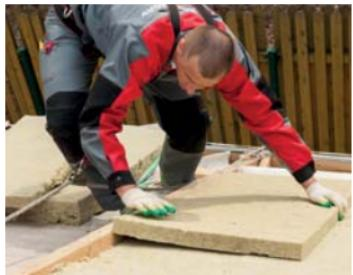
Теплоизоляционные плиты монтируются в распор между стропилами. При утеплении в несколько слоев плиты укладывать с перекрытием швов.
