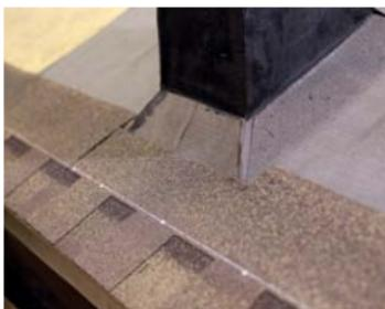
При устройстве примыкания к трубе необходимо устроить галтель\* в месте стыка ската кровли с вертикальной поверхностью. Завести подкладочный ковер на галтель, затем подрезать по месту.
