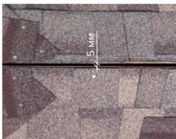
Подрезать рядовую черепицу, выходящую на ребро, таким образом, чтобы между покрытиями смежных скатов было расстояние шириной 5 мм.
