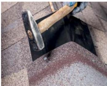
Фиксация производится на 2 гвоздя длиной не менее 60 мм, ориентируясь на линию пришивания гвоздей, отформованную на коньковом аэраторе
