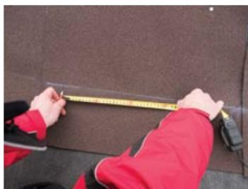
Отмечаем засечки каждые 330 мм на горизонтальной линии под шаг выкроек из гибкой черепицы.
