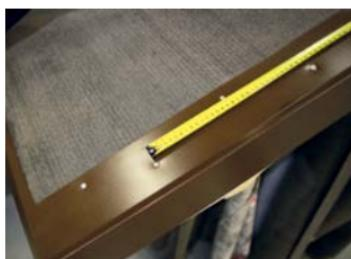
Планку крепить специальными кровельными гвоздями в шахматном порядке с шагом 120–150 мм.
