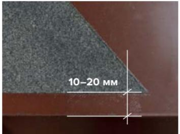
На карнизном свесе самоклеящийся подкладочный ковер подрезается и укладывается так, чтобы до перегиба карнизной планки остался зазор 10–20 мм. На нижнем краю ендовой ковер необходимо подрезать с небольшим закруглением («язычком»), для того чтобы закрыть стыки карнизных планок в ендовой и обеспечить правильный отвод воды.
