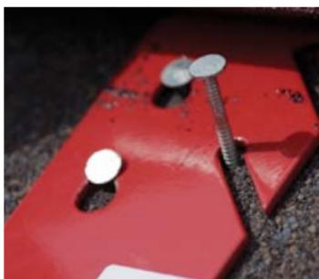
Кронштейны фиксируются на кровельные гвозди или саморезы.
