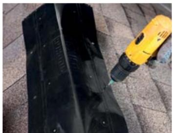
Фиксация аэроэлемента производится кровельными гвоздями или саморезами длиной не менее 41 мм в местах, заранее размеченных на заводе-изготовителе.
