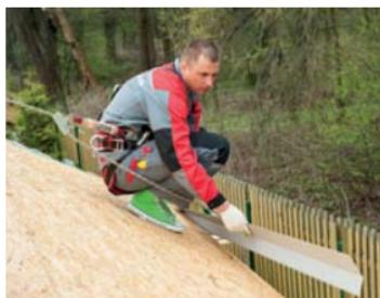
Карнизный свес кровли усиливается металлическими карнизными планками.
