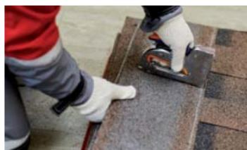
Допускается дополнительное усиление ламинации гонта с помощью строительного степлера оцинкованными скобами.
