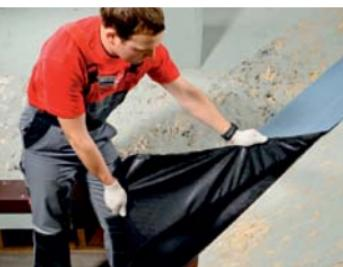
Затем таким же образом удаляется пленка со второй половины подкладочного ковра.
