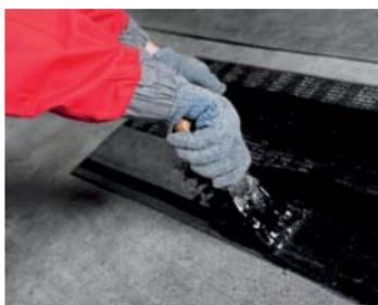
В случае устройства выкройки из рядовой черепицы или использования рядовой черепицы в качестве стартовой полосы необходимо промазать тыльную сторону в зоне отсутствия клейкого слоя мастикой ТЕХНОНИКОЛЬ ФИКСЕР, толщиной не более 1 мм.
