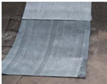
Механически зафиксировать подкладочный ковер, промазать нахлесты мастикой ТЕХНОНИКОЛЬ ФИКСЕР.
