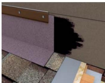
Механически закрепить планку примыкания. Произвести герметизацию фартука силиконовым, тиоколовым или полиуретановым герметиком.
