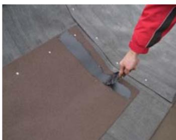
Механически зафиксировать ендовый ковер, промазать нахлести мастикой ТЕХНОНИКОЛЬ ФИКСЕР. Нахлест должен быть не менее 100 мм.
