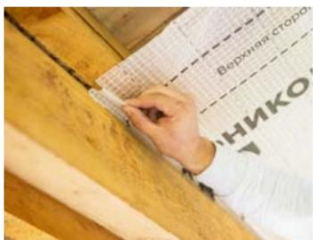
Маркированная сторона пленки должна быть обращена к монтажнику. Монтаж пленок производится внахлест (примерно 10 см), на каждый рулон нанесены марковочные линии. Пленку следует монтировать с натягом, не допуская провиса и складок, чтобы надежно проклеить нахлест рулонов и исключить деформацию утеплителя.
