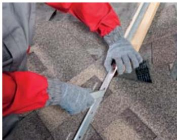
Подрезать рядовую черепицу с более крутого ската по мелованной линии подреза, используя специальную деревянную дощечку, чтобы не повредить целостность гидроизоляционного слоя.
