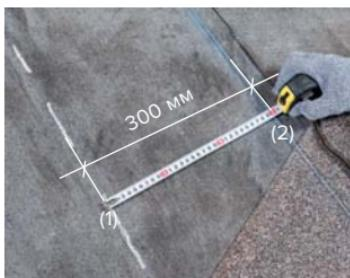
Произвести разметку на подкладочном ковре линии фиксации (2) гибкой черепицы на расстоянии не менее 300 мм от оси ендовы (1).
