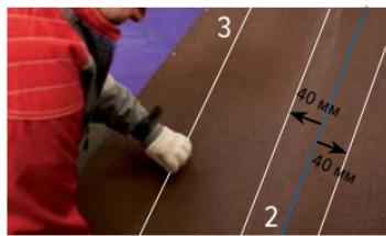
Проведите отбивку мелованных линий установки вертикального гонта и линий фиксации вертикального гонта с помощью шнурки-отбивки.
