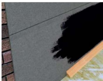
При устройстве бокового примыкания обязательно требуется галтель.
