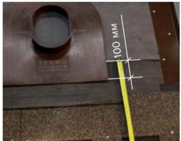
Если нет возможности для условия захода нижнего края проходного элемента на гибкую черепицу, то для соблюдения этого правила необходимо изготовить вырезку из подкладочного ковра таким образом, чтобы ковер заходил под проходку не менее чем на 100 мм.
