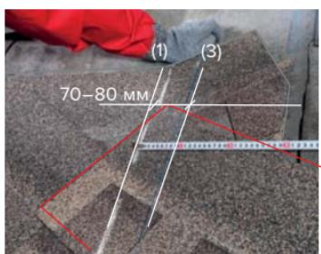
Произвести отбивку мелованной линии подреза (3) на более крутом скате с помощью шнурки (отбивки) (на расстоянии 70–80 мм от оси ендовы).
