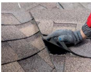
**ВАЖНО!** Необходимо наносить мастику не только на черепицу малоуклонного ската, но и на нижележащий гонт гибкой черепицы с более крутого ската для надежной изоляции.
