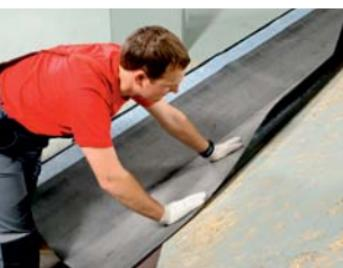
Эта часть подкладочного ковра приклеивается к основанию. В момент приклеивания следует аккуратно разглаживать полотно, избегая образования складок.
