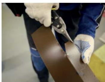
Перед выполнением ендовой или ребра карнизную планку необходимо подрезать по месту, оставляя часть планки для завода на противоположный скат.
