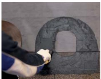
Нанести битумную мастику ТЕХНОНИКОЛЬ ФИКСЕР на основание или нижнюю сторону юбки проходного элемента, затем приkleить к основанию.
