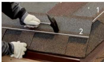
Монтаж рядовой черепицы по горизонтали произведите от линии установки вертикального гонта. Механическая фиксация должна осуществляться на расстоянии 300 мм от оси ендовой. Таким же образом установить рядовую черепицу на соседнем скате.
