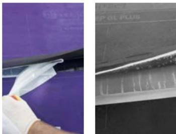
Продольные перехлести ковров ANDEREP GL PLUS и ANDEREP PROF PLUS формируются с помощью клеевых монтажных полос. Для формирования перехлеста необходимо одновременно снять защитные пленки с клеевых полос верхнего и нижнего полотен и плотно прижать их друг к другу.
