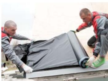
Затем при克莱ить оставшуюся часть полотна, одновременно раскатывая и снимая защитную пленку с рулона.
