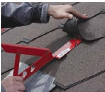
Для перемещения людей и удобства работы с материалами во время монтажа кровельного покрытия использовать регулируемые кронштейны лесов-подмостей ТЕХНОНИКОЛЬ.
