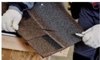
Срежьте угол гонта, выступающий за пределы ската таким образом, чтобы до края карнизной планки осталось 10–20 мм.
