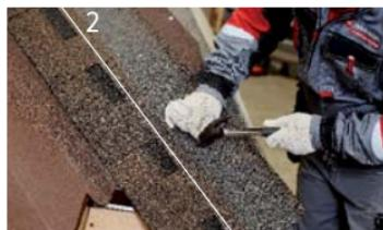
Смонтируйте подготовленные гонты параллельно оси ендовой по линии на кровельные гвозди по 5–8 гвоздей на рядовую черепицу в зависимости от угла наклона кровли. До  $45^{\circ}$  — 4 гвоздя, выше — 8 гвоздей.
