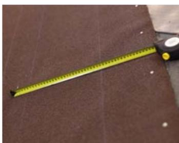
Зафиксировать с лицевой стороны ендовный ковер специальными кровельными гвоздями с отступом от края 20–30 мм с шагом 200–250 мм.
