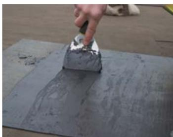
Сделать выкройку из ендового ковра для герметизации перехода горизонтального ската на вертикаль купола.
