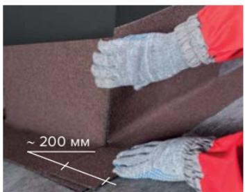
В последнюю очередь монтировать тыльную выкройку, которая заводится под черепицу таким образом, чтобы в дальнейшем выполнить желоб между черепицей и галтелью шириной 80 мм.
