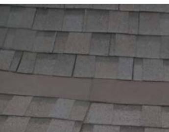
Монтируем последующие ряды гибкой черепицы, смещающая швы гибкой черепицы на половину ширины выкройки. Подрезаем гибкую черепицу по вертикальным линиям разметки. Смонтировать гибкую черепицу на нижележащем скате, заводя ее под ендовый ковер в месте перехода на купольную часть.
