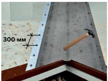
При температуре от 0 до +10 °C необходимо дополнительно закрепить подкладочный ковер кровельными гвоздями с широкой шляпкой. Расстояние между гвоздями составляет 300 мм.
