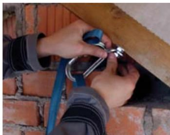
Анкерная точка с использованием шпильки Ø10–12 мм.
