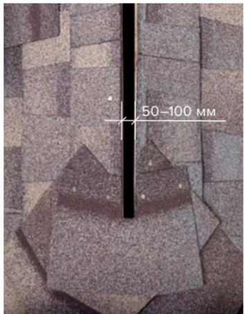
Вдоль конька в сплошном основании прорезается отверстие шириной 50–100 мм.
