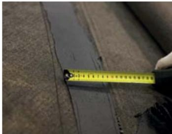
Ендовный ковер промазать по периметру тыльной стороны битумной мастикой ТЕХНОНИКОЛЬ ФИКСЕР на ширину 100 мм.
