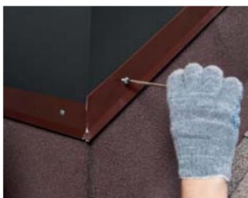
Механически закрепить планку примыкания.
