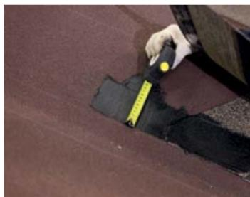
Промазать черепицу битумной мастикой ТЕХНОНИКОЛЬ ФИКСЕР с тыльной стороны на величину 100 мм в местах отсутствия самоклеящегося слоя, толщиной не более 1 мм.
