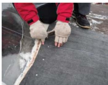
Смонтировать подкладочный ковер, для удобства ориентации подкладочного ковра его центр должен совпадать с размеченной вертикальной линией:
