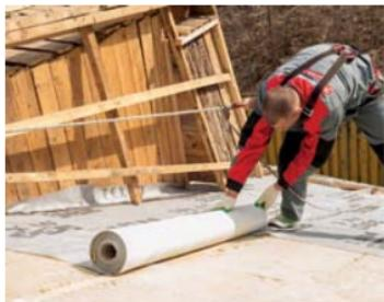
При укладке мембраны про-извести перехлест полотен не менее 100 мм по горизонтали и по вертикали. Перехлести полотен проклеиваются с помощью монтажной акри-ловой или бутил-каучуковой ленты.
