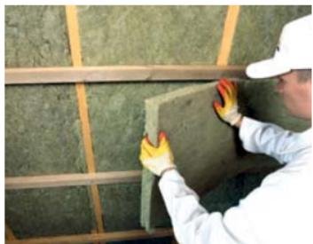
Необходимо установить дополнительную деревянную или металлическую обрешетку нужной толщины со стороны помещения. Направляющие для каркаса устанавливаются поперек стропил для того, чтобы перекрыть возможные мостики холода. В получившийся дополнительный каркас уст-
