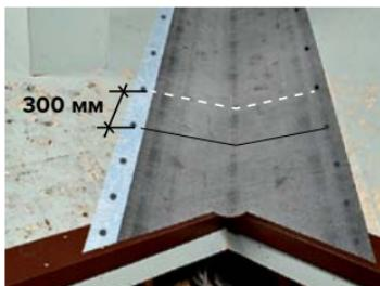
части. Ширина поперечного перехлеста в зоне ендовы составляет 300 мм.
