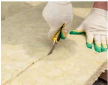
Для резки теплоизоляционных материалов из каменной ваты ТЕХНОНИКОЛЬ или плит LOGICPIR PROF Ф/Ф используйте ножовку или нож. Не допускается ломать плиты утеплителя.
