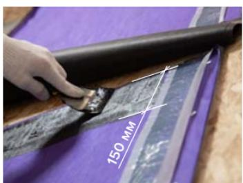
Места поперечных перехлестов механически закрепляемых подкладочных ковров обрабатываются битумной приклеивающей мастикой ТЕХНОНИКОЛЬ № 23 (Фиксер). Толщина слоя нанесения мастики не более 1мм. Ширина поперечного перехлеста составляет 150 мм.
