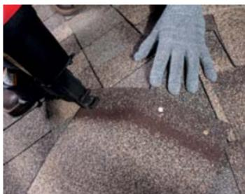
Укладываем черепицу снизу вверх после отбивки габаритов будущего ребра (две полосы вдоль ребра) с помощью шнурки (отбивки).
