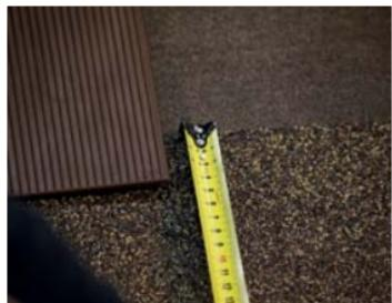
Проходной элемент уложить таким образом, чтобы его нижний край заходил на рядовую гибкую черепицу не менее чем на 20 мм.
