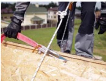
Осуществить подъем по вертикальной анкерной линии на конек крыши. Установить горизонтальную анкерную линию, соединив ее с заранее выведенными петлями на конек.
