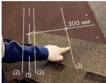
На каждой поверхности ската зафиксировать каждый гонт гибкой черепицы с помощью кровельных гвоздей по линии фиксации (3) (на расстоянии не менее 300 мм от оси ендовы (1)).
