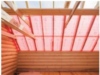
Нахлест полотен составляет 100–200 мм. Швы и места крепления пленки степлером герметизируются с помощью герметизирующих лент ТЕХНОНИКОЛЬ АЛЬФАБЭНД.
