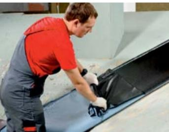
С одной части подкладочного ковра удаляется защитная пленка.
