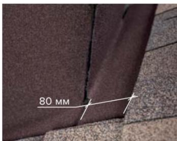
Произвести укладку гибкой черепицы с тыльной стороны. Гибкая черепица заводится на выкройку из ендового ковра таким образом, чтобы желоб между черепицей и галтелью был шириной 80 мм.
