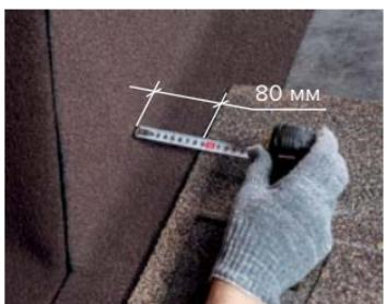
Произвести укладку гибкой черепицы. На левой и правой частях гибкая черепица заводится на выкройки из ендовного ковра таким образом, чтобы желоб между черепицей и галтелью был шириной 80 мм.
