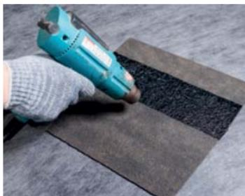
Если кровельные работы проводятся при температуре ниже +5°C, упаковки с гибкой черепицей ТЕХНОНИКОЛЬ SHINGLAS следует подавать по 5–6 пачек, выдержаных не менее 24 часов в помещении с температурой воздуха не менее +20°C или в организованном на строительной площадке тепляке,
