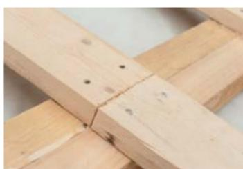
Поперечное соединение двух элементов разреженной обрешетки в одном ряду производить таким образом, чтобы стык досок приходился на стропильную ногу, механическая фиксация по 2 шт. на каждый край доски.
