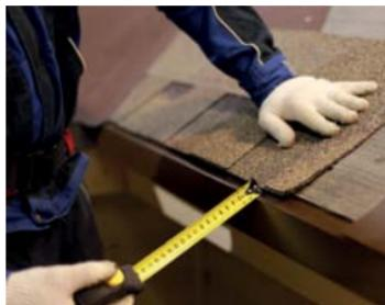
Коньково-карнизная черепица, выкройка из рядовой черепицы или рядовая черепица наклеиваются поверх подкладочного ковра с отступом от места перегиба карнизной планки 10–20 мм.
