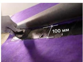
Продольный перехлест подкладочных ковров составляет 100 мм. Места продольных перехлестов подкладочных ковров ANDEREP PROF и ANDEREP GL LIGHT промазываются битумной приклеивающей мастикой ТЕХНОНИКОЛЬ № 23 Фиксер, толщиной не более 1мм.
