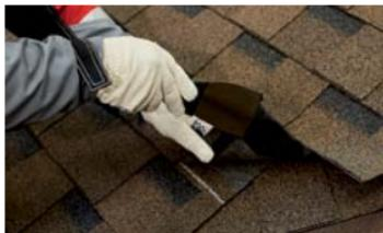
С тыльной стороны гонта, который подходит к ендove, в местах отсутствия клеящего слоя, на расстоянии 100 мм нанесите битумную мастику ТЕХНОНИКОЛЬ ФИКСЕР, толщиной строго не более 1 мм.
