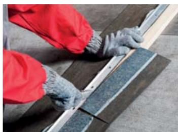
В случае устройства выкройки из рядовой черепицы проинвести подрезку лепестков гонта по заранее размеченной линии.
