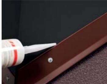
Произвести герметизацию планки примыкания силиконовым, тиоколовым или полиуретановым герметиком.
