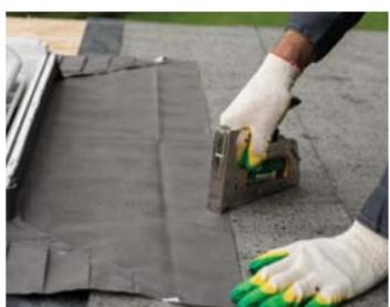
Если на крыше уже смонтировано сплошное основание, то необходимо установить фартук вокруг рамы окна и закрепить к основанию с помощью степлера.
