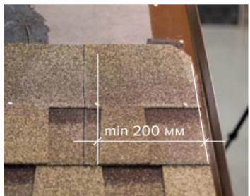
Вырезку из рядовой гибкой черепицы шириной не менее 200 мм следует закрепить минимум 2 кровельными гвоздями.
