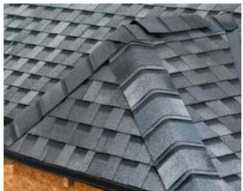
Для придания объемного вида конькам и ребрам можно использовать метод двойного конька. Метод заключается в наложении друг на друга элементов коньково-карнизной черепицы со смещением в 2 см.
