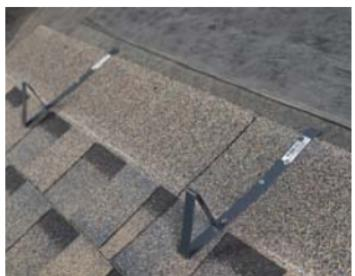
Снегозадержатель для гибкой черепицы механически фиксировать к основанию кровли через подкладочный ковер.
