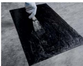
Нанести битумную мастику ТЕХНОНИКОЛЬ ФИКСЕР на всю тыльную поверхность выкройки ендового ковра ТЕХНОНИКОЛЬ. Полоса ендового ковра должна быть шириной не менее 500 мм.
