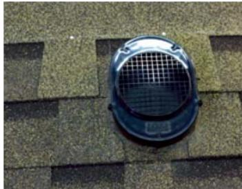
Далее на проходной элемент монтировать необходимый кровельный выход.
