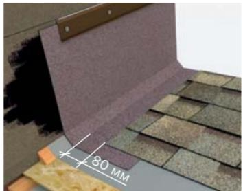
Механически закрепить металлический фартук. Произвести герметизацию фартука силиконовым, тиоколовым или полиуретановым герметиком. Гибкая черепица заводится на выкройку из ендовного ковра таким образом, чтобы желоб между черепицей и галтелью был шириной 80 мм.
