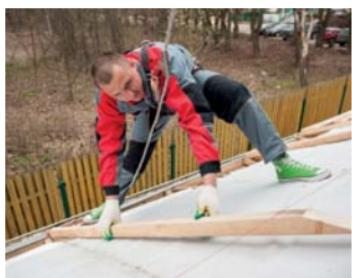
Для нормального функционирования кровли необходимо обеспечить надлежащую вентиляцию. Система подкровельной вентиляция включает в себя три основных элемента: отверстие для притока свежего воздуха (обычно бывает в районе карниза), вентилируемый зазор (канал над теплоизоляционным слоем) для циркуляции воздуха и вытяжные отверстия в верхней части кровли (обычно бывает в районе конька).
