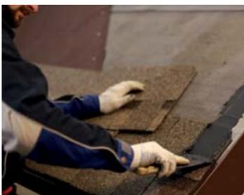
Битумная мастика наносится как на торцевую планку, так и на невидимую часть гонта черепицы, который подходит к торцевой планке. Нанести битумную мастику ТЕХНОНИКОЛЬ ФИКСЕР слоем толщиной не более 1 мм, полосой шириной 100 мм.
