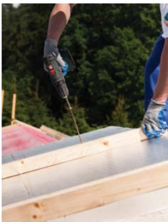
Плиты фиксировать с помощью специального крепежа Termoclip WST 5,5 через брус для создания вентиляционного зазора. Шаг бруса должен соответствовать шагу стропил.
